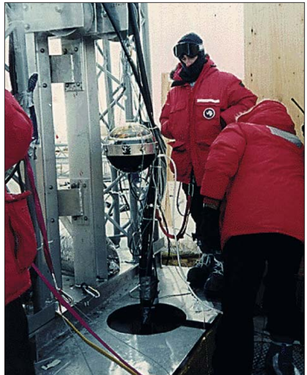
Гидродинамическое бурение на станции Амундсен-Скотт.
